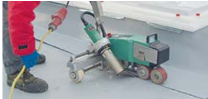
其细长的流线型设计使其可在接近场地边缘处进行焊接。
